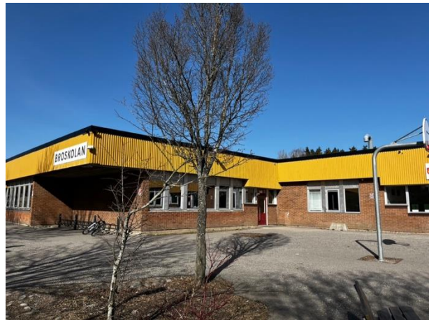
Das Schulgebäude der Broskolan.
