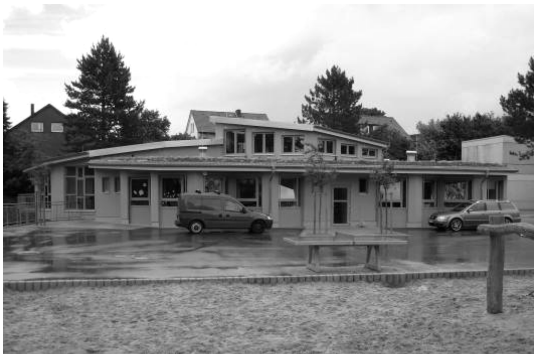
Abb. 8. Neubau der Grundschule Landsberger Strasse – Westansicht
